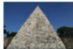
altura aproximada es de 36,4 metros. Aunque su estructura interna está elaborada en ladrillo, la parte externa está recubierta de mármol.
