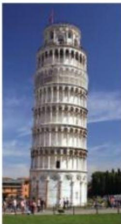
La Torre Inclinada de Pisa es una construcción en forma de cilindro que tiene aproximadamente 56 m de alto, 15,5 m de diámetro exterior y 7,4 m de diámetro interior. Fue construida entre 1173 y 1372.
