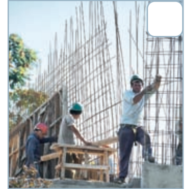
► Trabajadores construyendo un edificio en el centro de Santiago.
