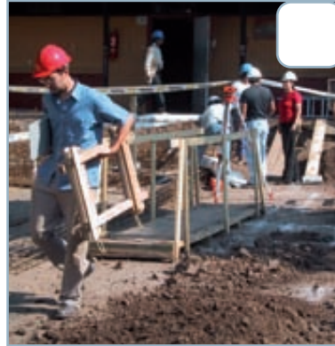
► Trabajadores y constructores reparando un colegio.
